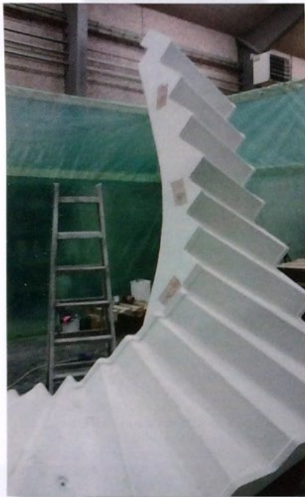
Vindeltrappe støbt i hvid beton.
